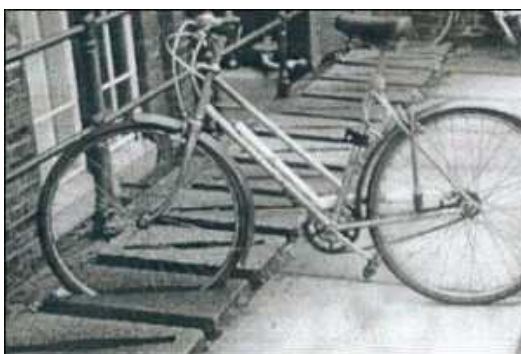
Suporte de concreto para encaixe entorta e arranha os aros
